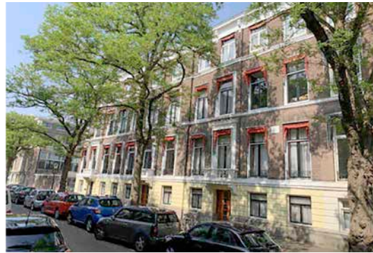
Voorgevel Amaliastraat in Den Haag
