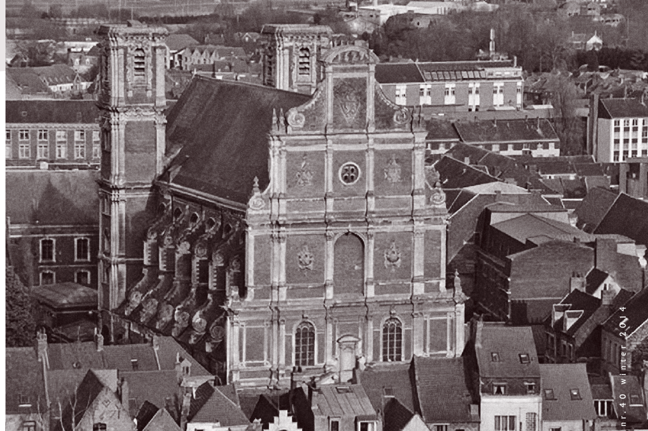
De voormalige jezuïetenkerk in Saint Omer
